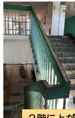
2階に上がる手すり
