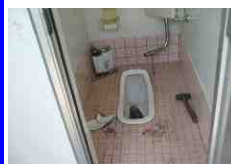
便器を壊して修理
